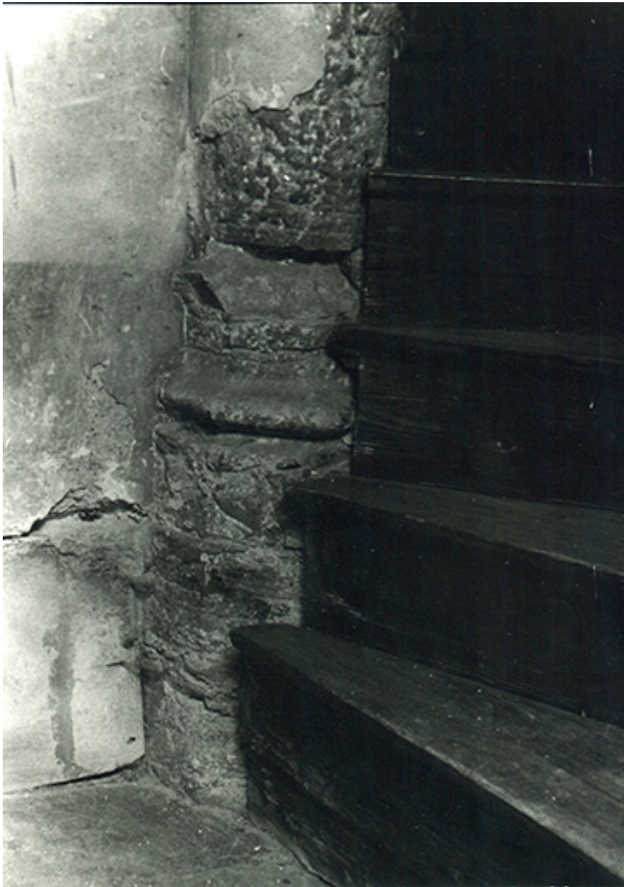
Escalier en vis (jonction entre la maison et l'aile nord du couvent). Base du noyau, 1979.
