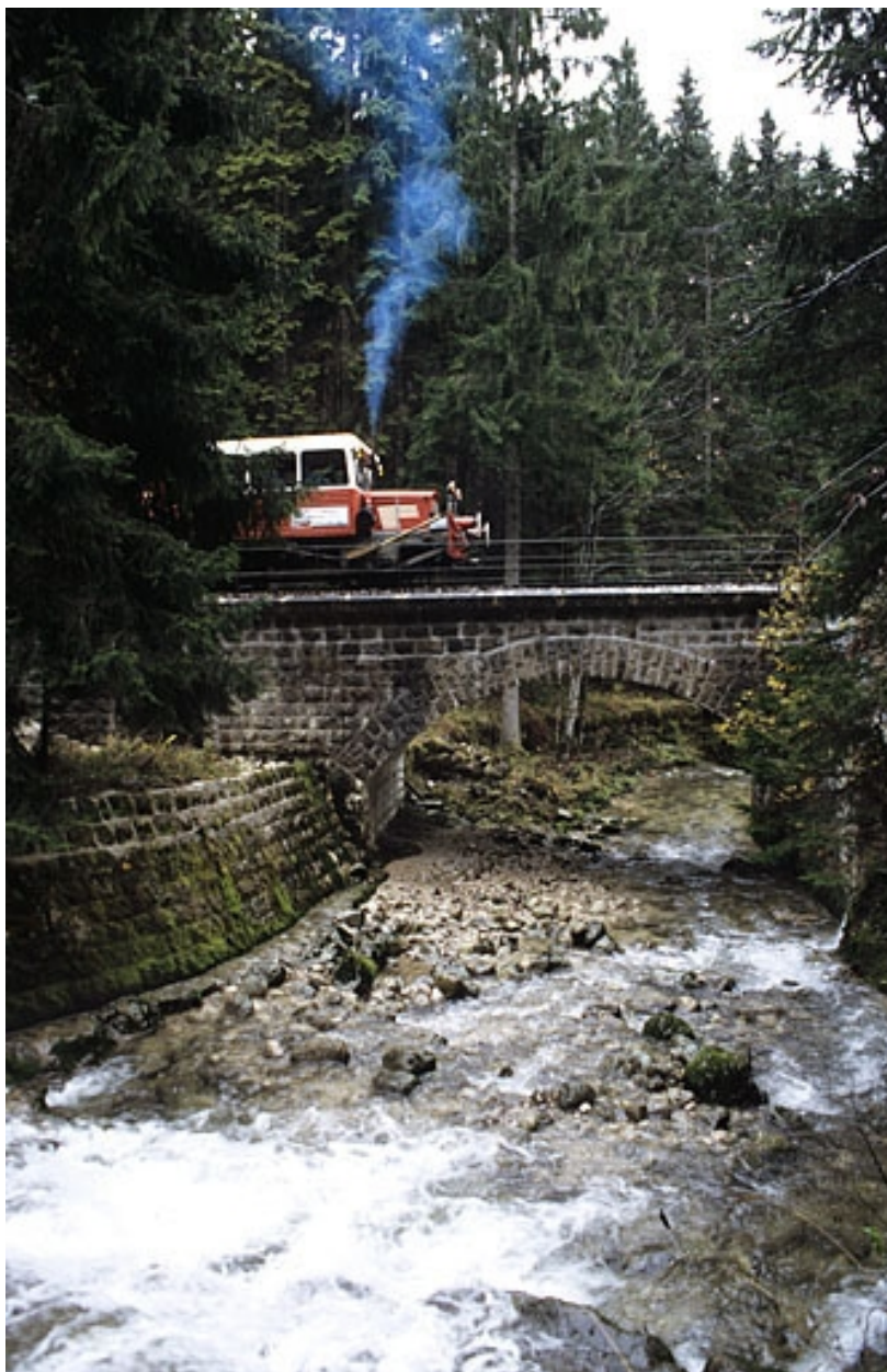
Elévation nord (amont), avec draine.
