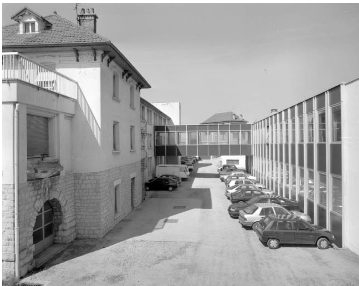
Ateliers de fabrication depuis le sud.
