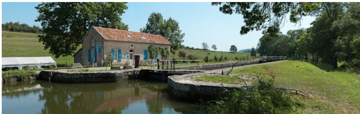
Vue du site d'écluse.
