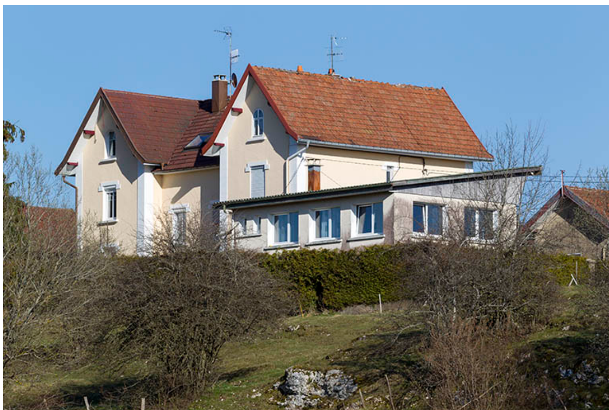
Vue d'ensemble, depuis l'ouest (maison et atelier).
