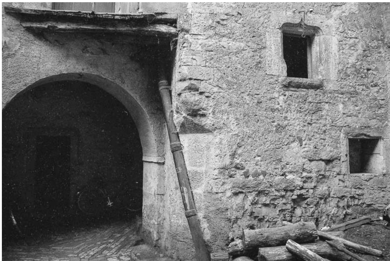
Accès à la tour d'escalier.
