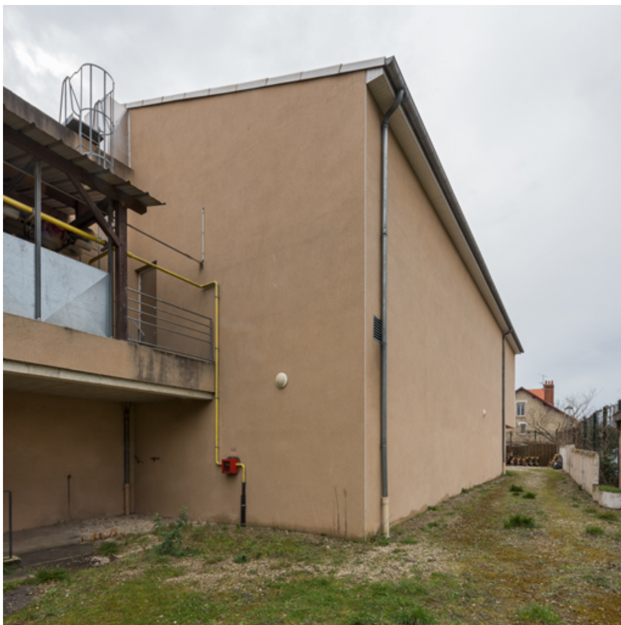
Salle 8, vue du nord.
