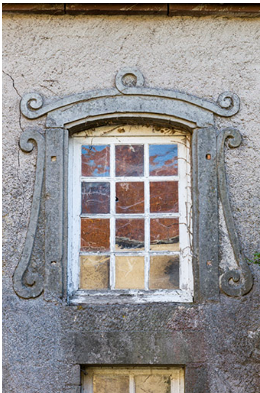
Détail d'une baie, façade ouest.
