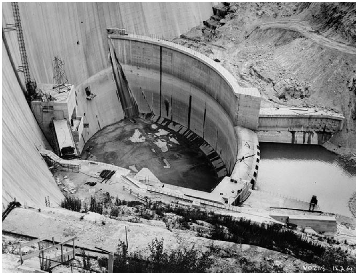
Bassin d'amortissement - Vue générale rive gauche.
