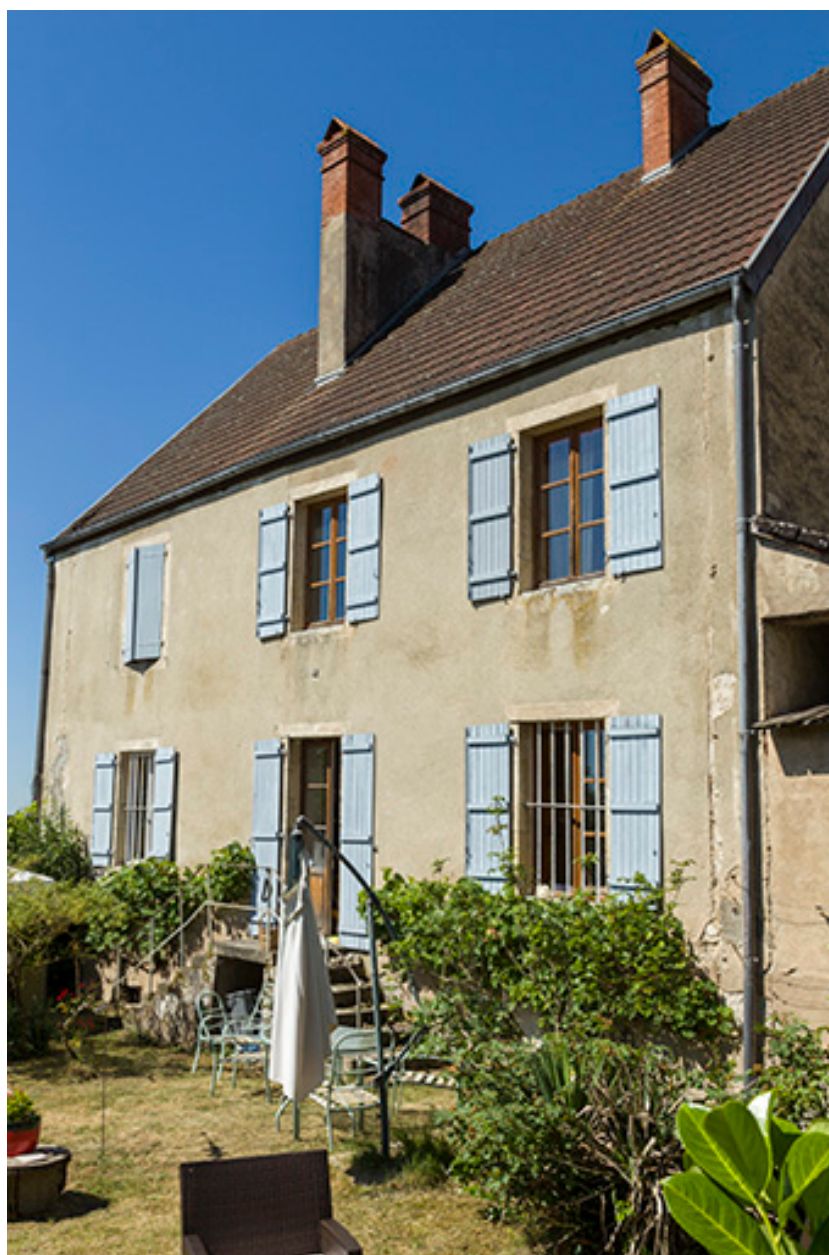
Façade postérieure du logis, côté jardin.
