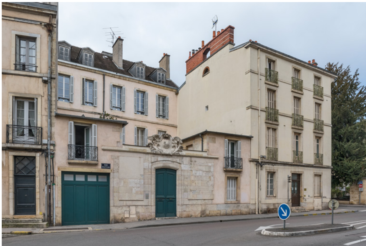
Tripot des Barres ou ancienne Comédie (8 rue Buffon) : vue d'ensemble dans la rue.
