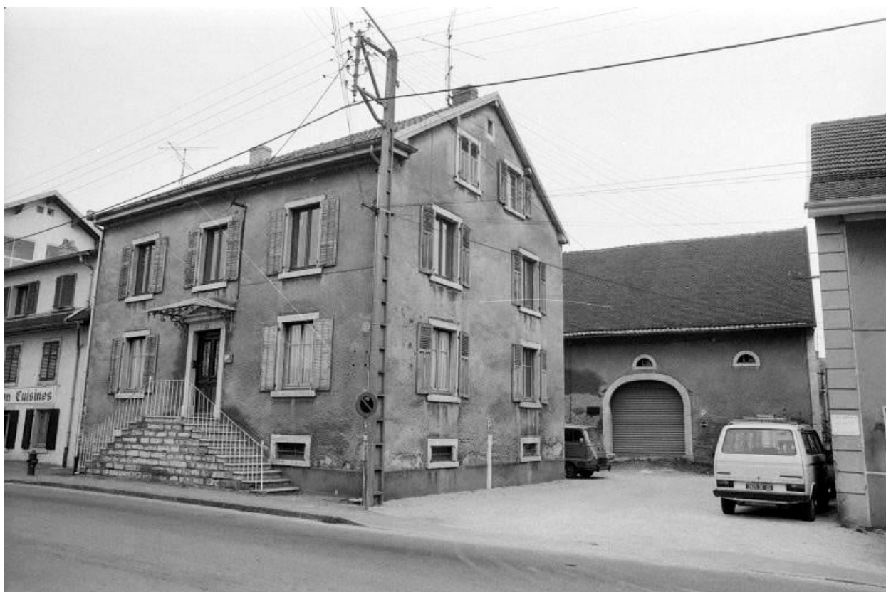
Audincourt : maison située 16 rue de Belfort.
