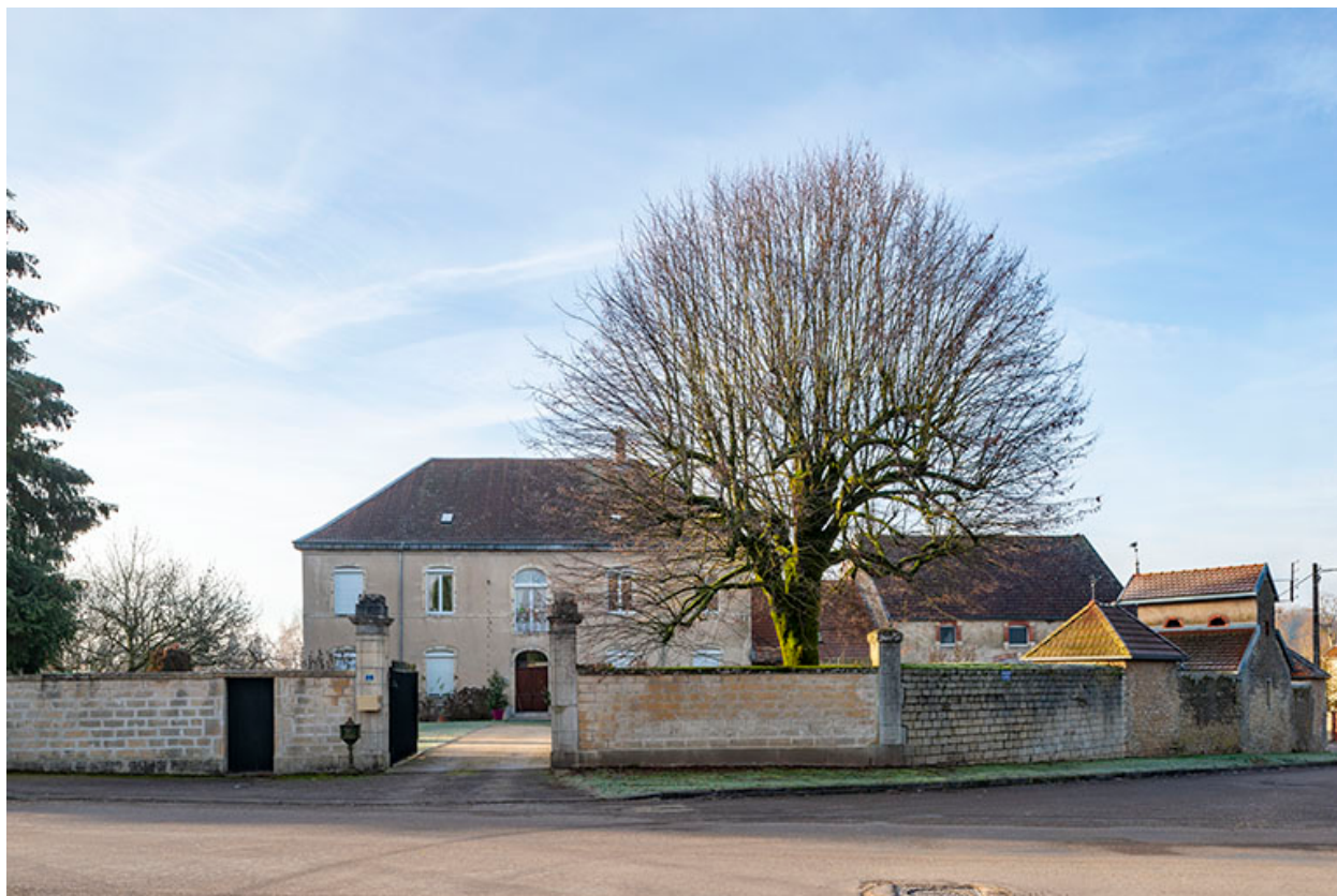
Vue générale depuis la route de Ferrières.
