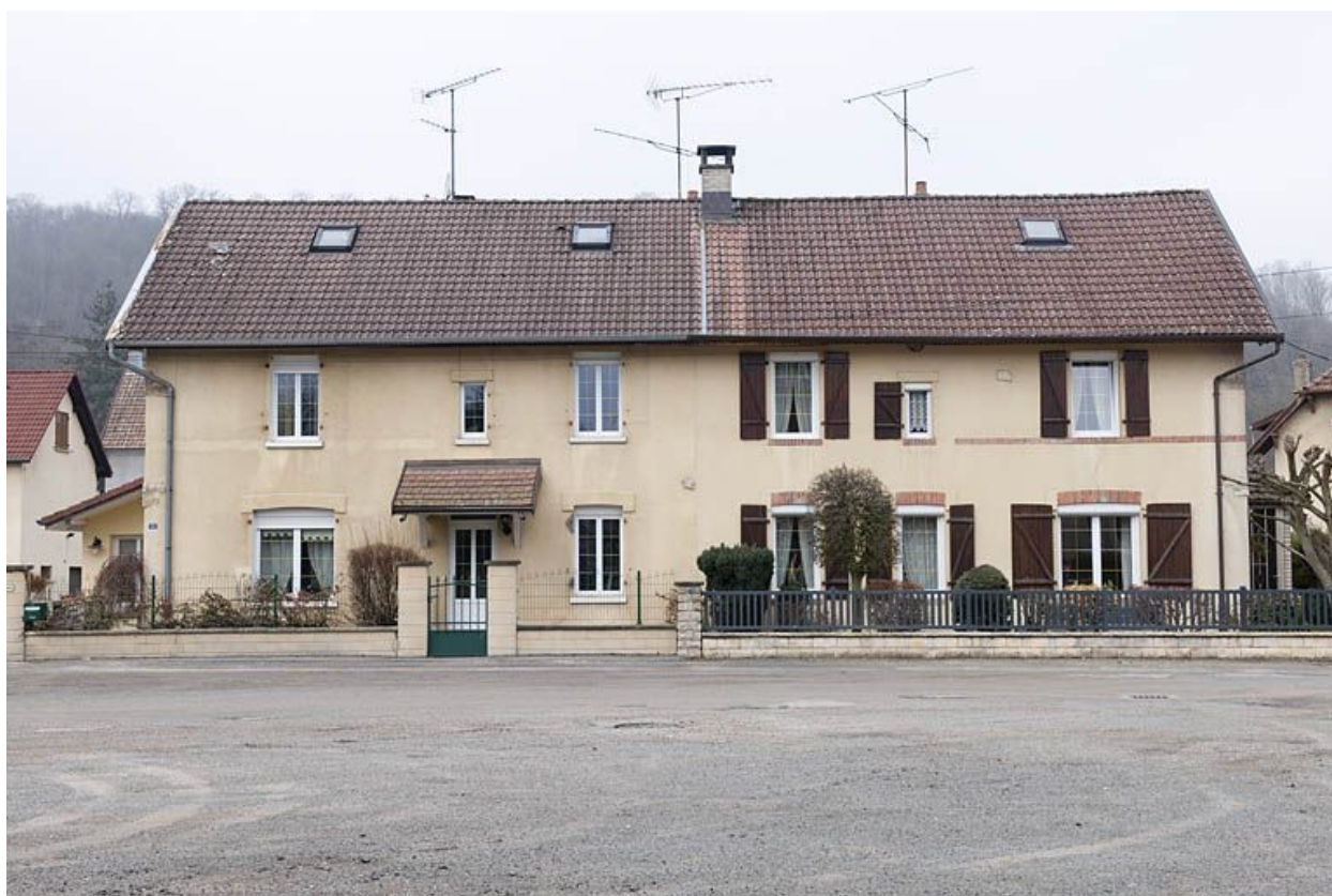
Immeuble à 4 logements. Façade est.
