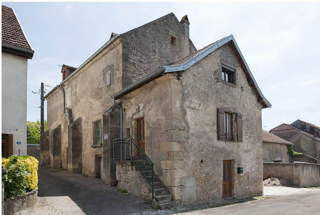
Vue générale depuis la rue Catinat.
