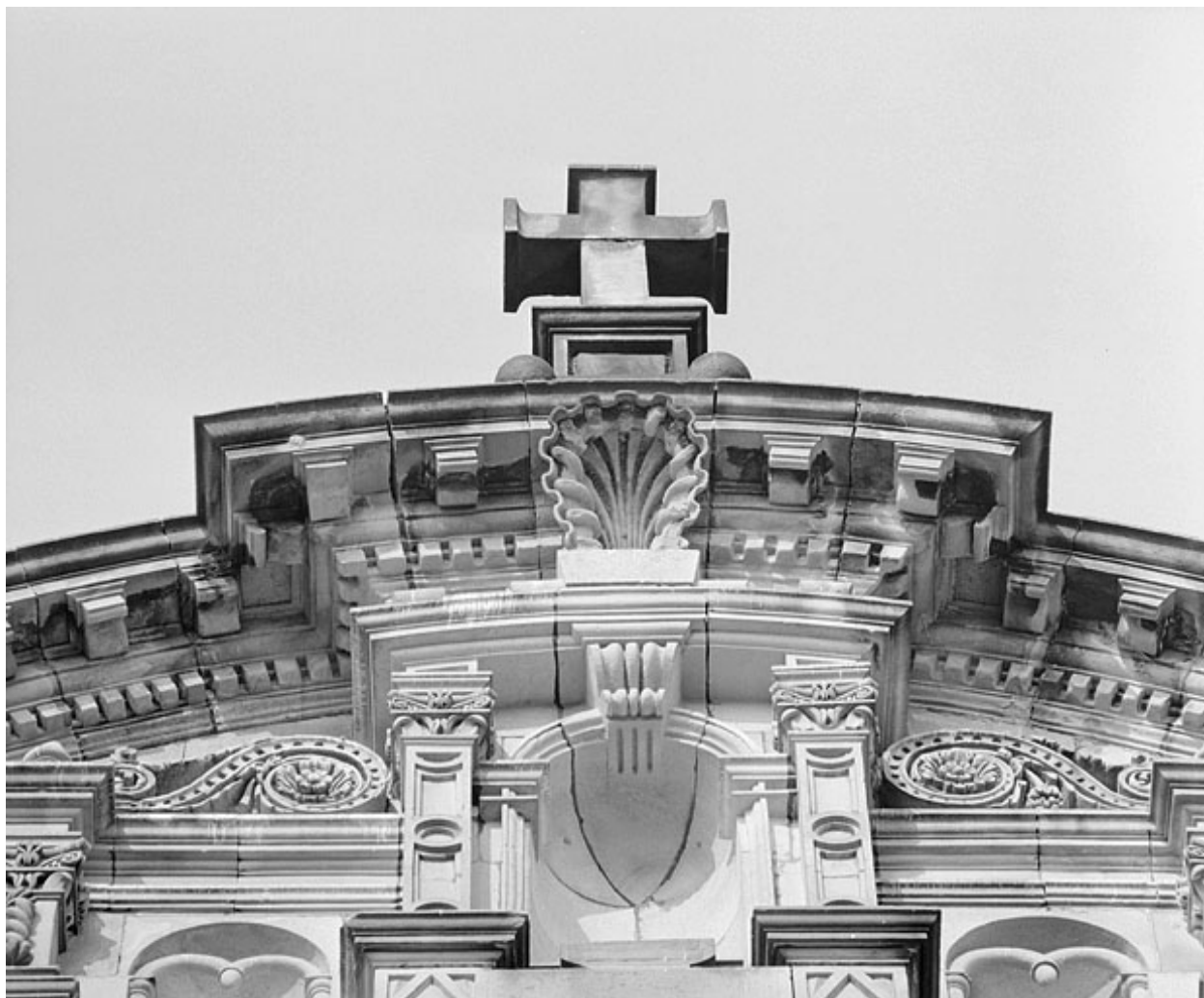
Façade principale, fronton vu d'en dessous.
