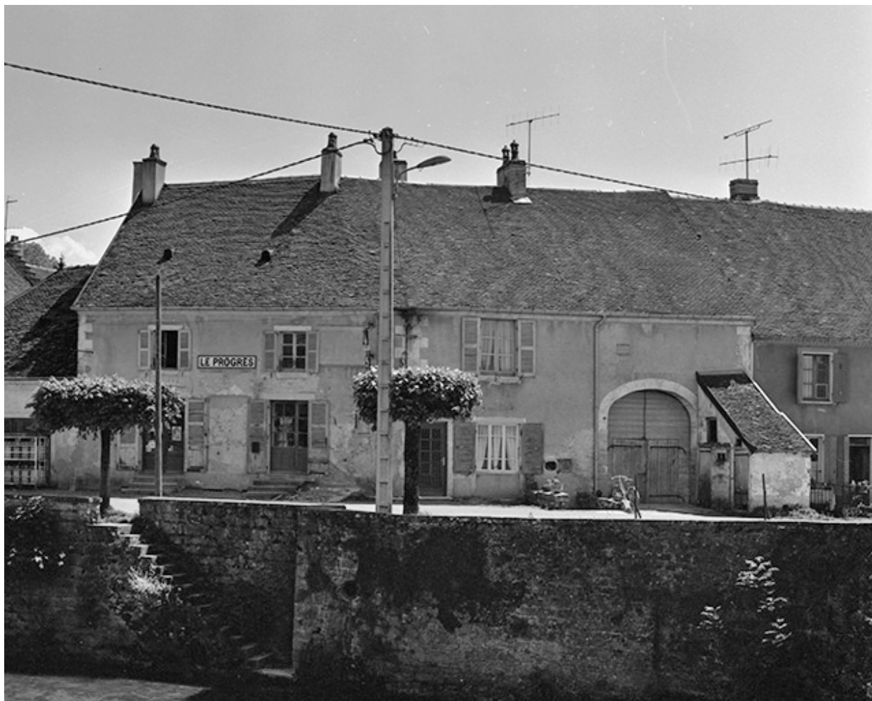
Ferme cadastrée AI 29-30 : façade antérieure.
