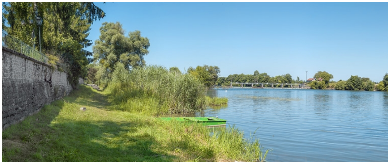
Vue d'ensemble d'aval.
