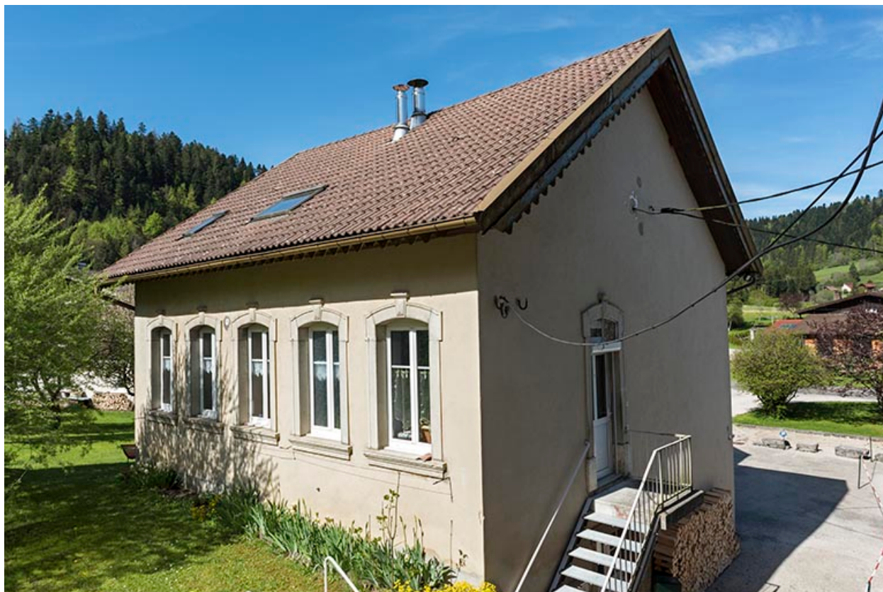
Maison : façades postérieure et latérale gauche.
