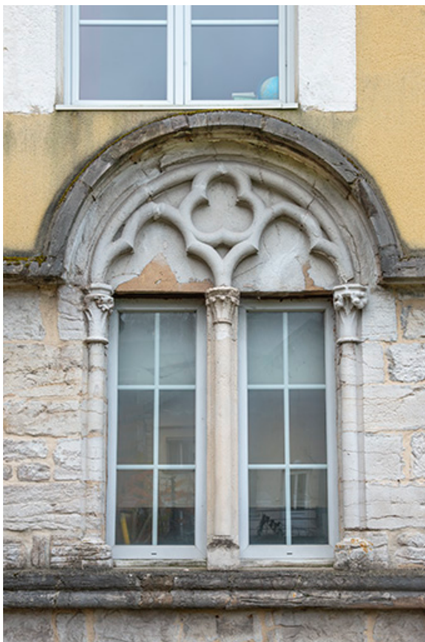
Façade nord. Détail de la fenêtre gauche.
