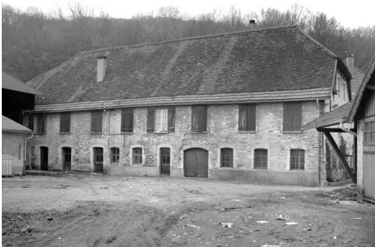
Moulin à papier (?), puis logements d'ouvriers.
