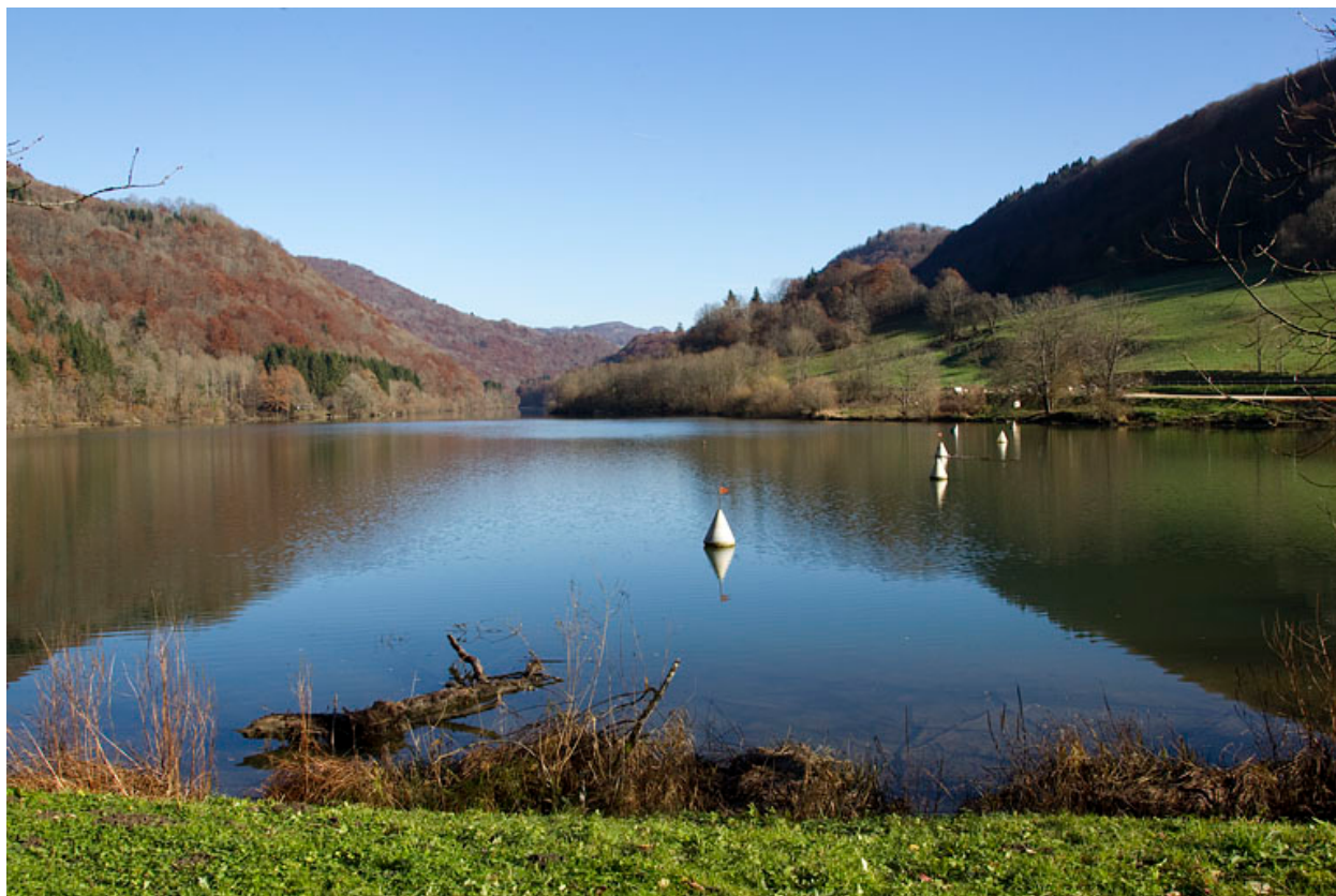
Bassin de retenue depuis la rive droite.
