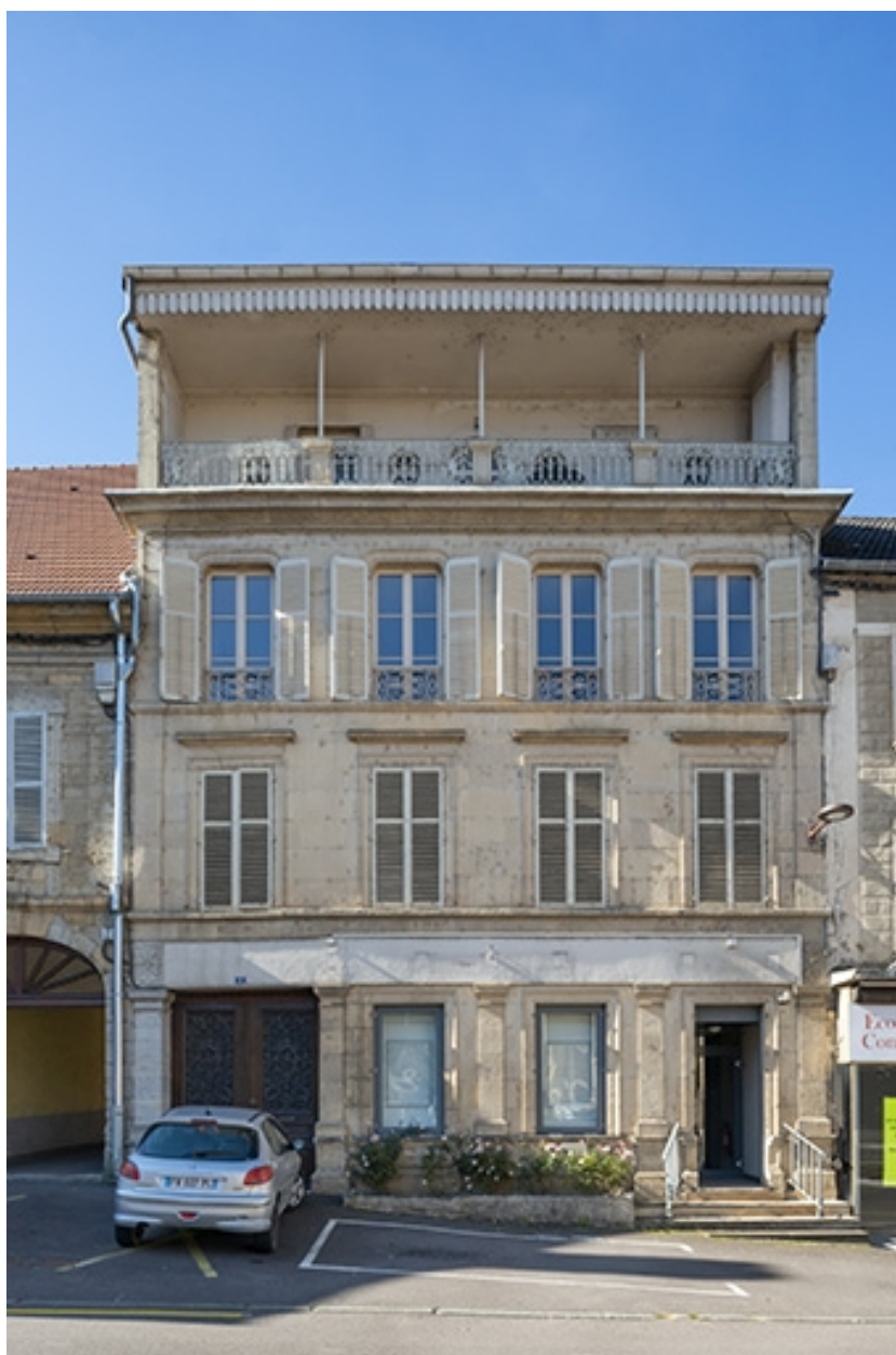
Façade de l'immeuble sur la rue.
