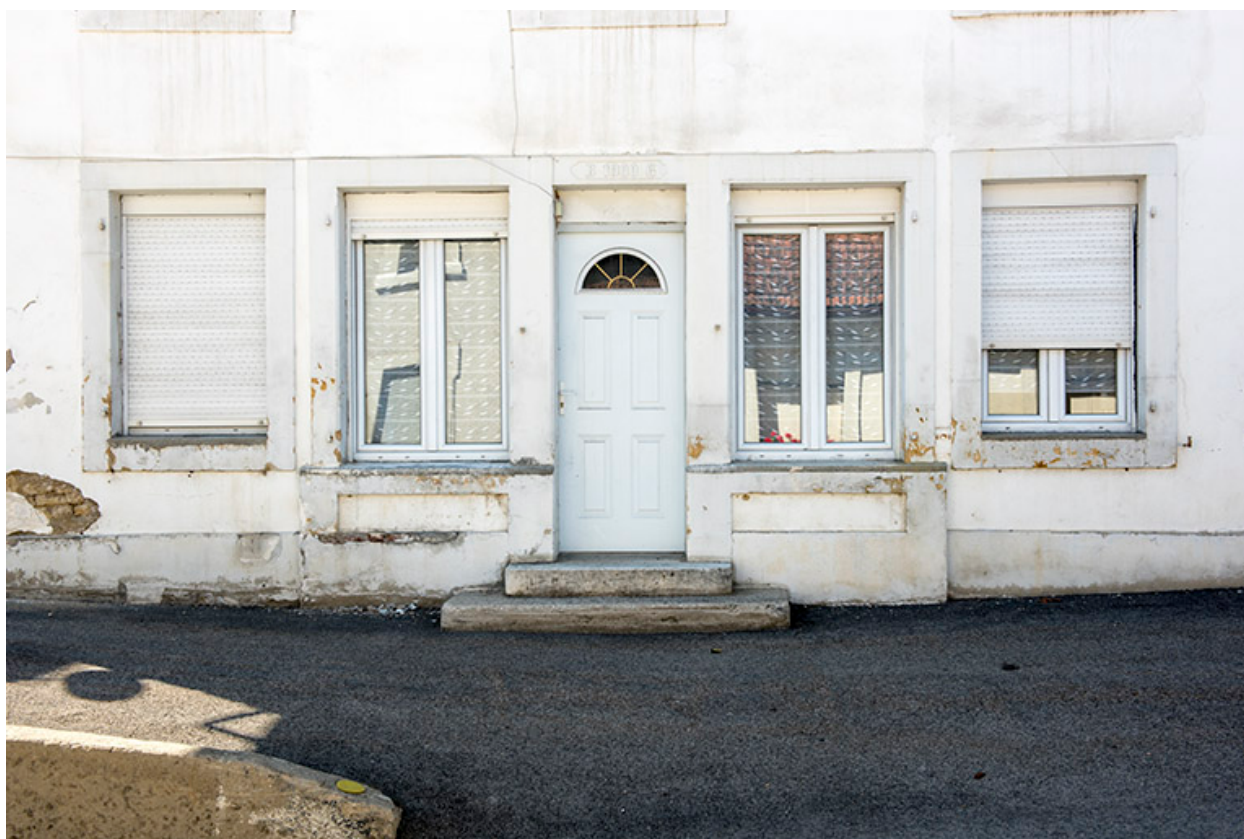
Façade antérieure : baies de l'étage de soubassement.
