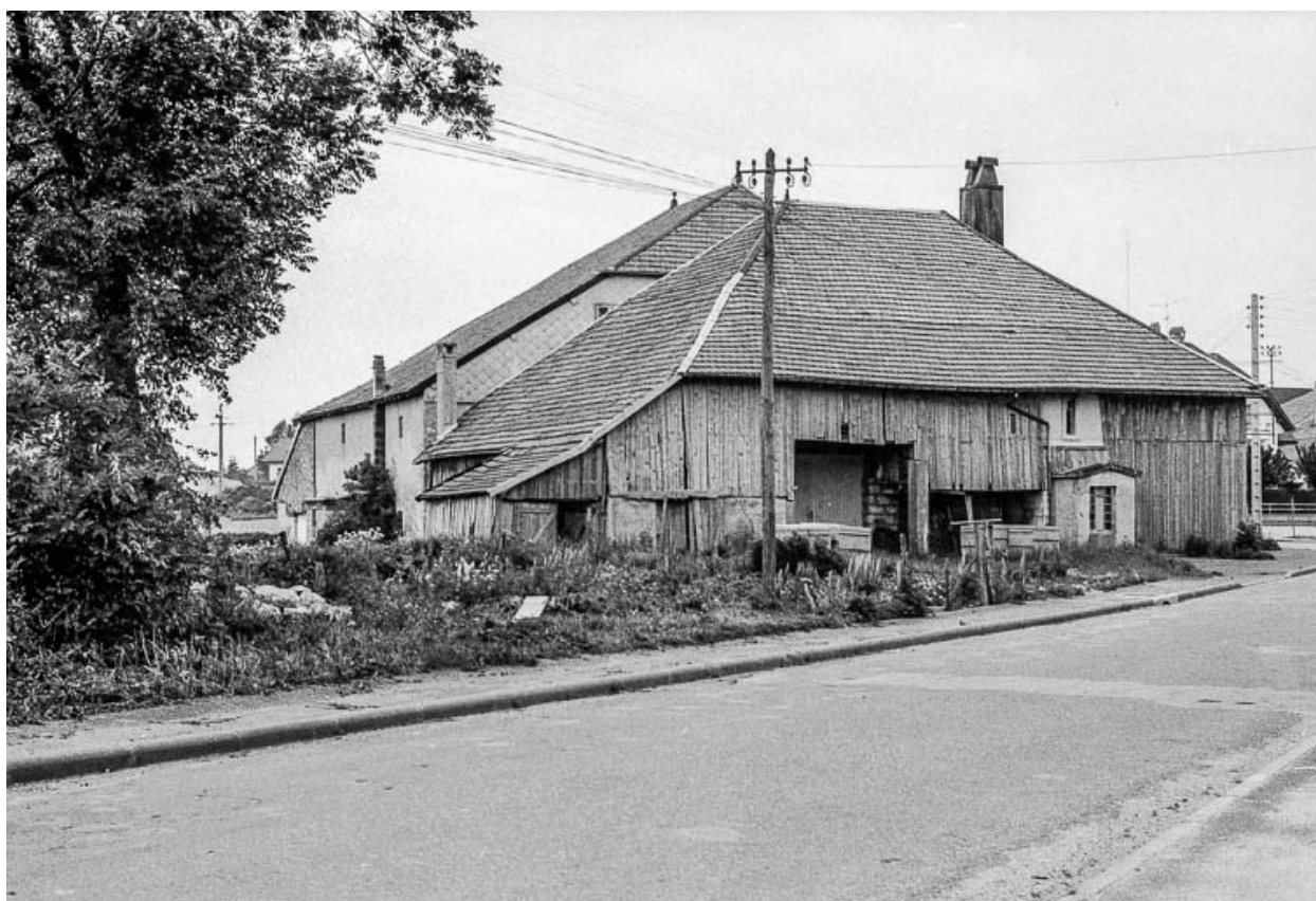
Ferme datée de 1797 : façade sur rue.
