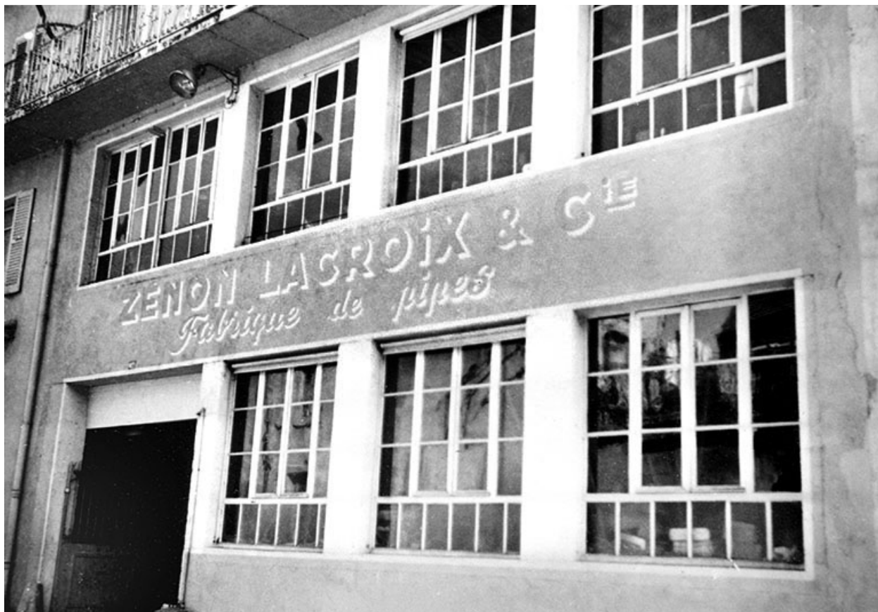
Façade antérieure du n° 8 bis.
