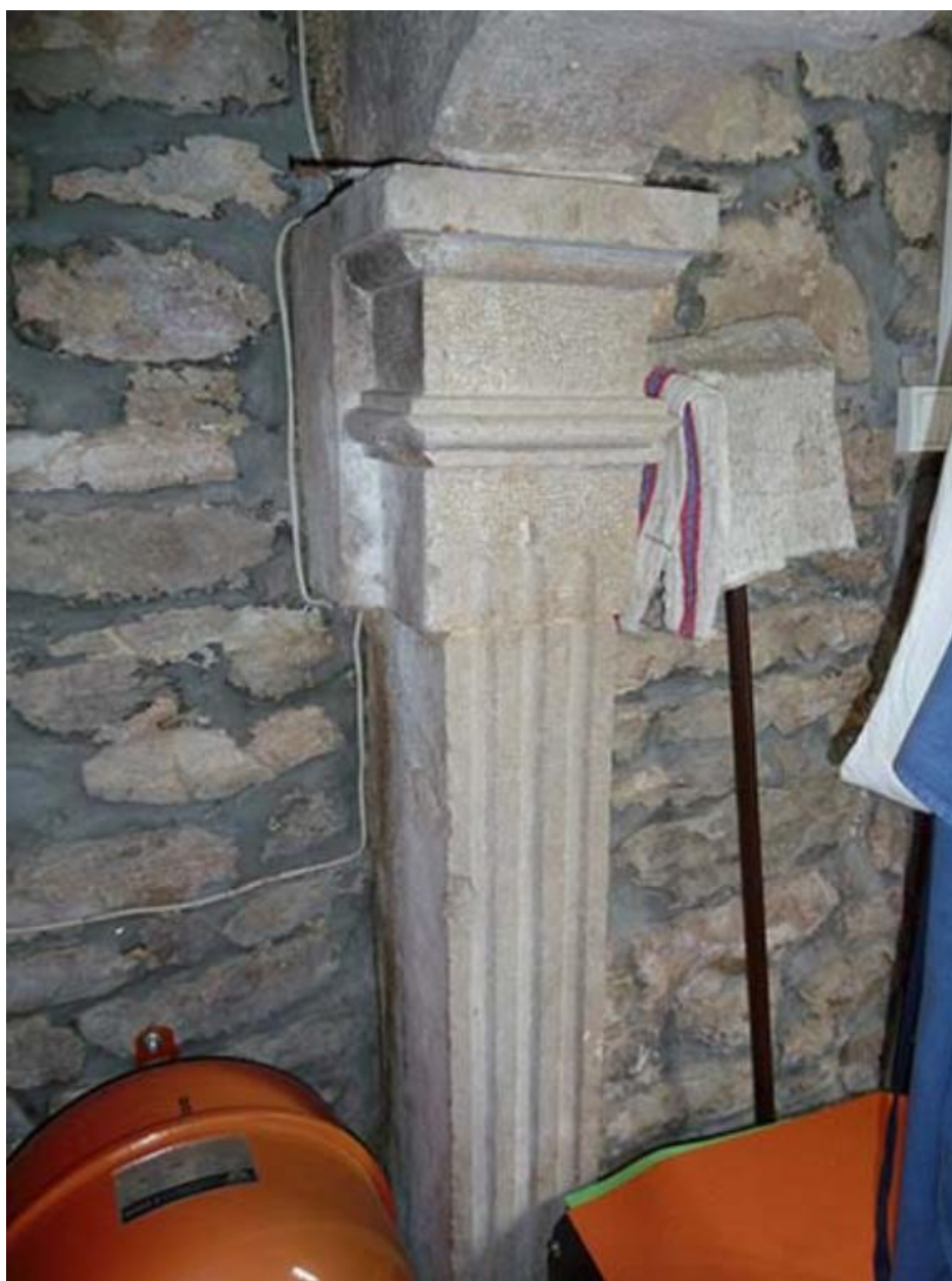
Détail du piédroit
