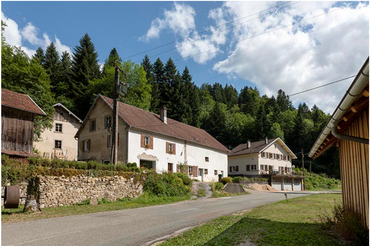
Logements, vus du nord.
