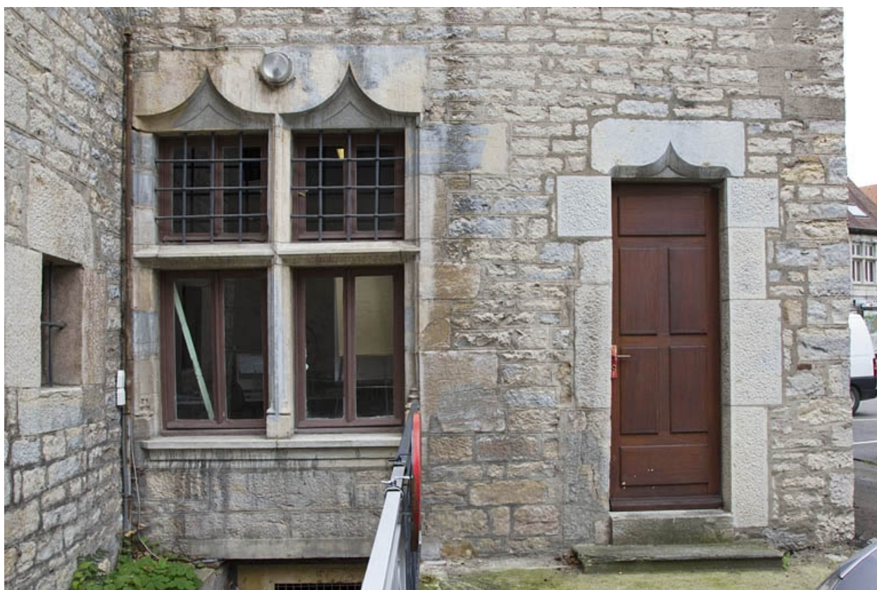
Façade postérieure : détail du rez-de-chaussée.
