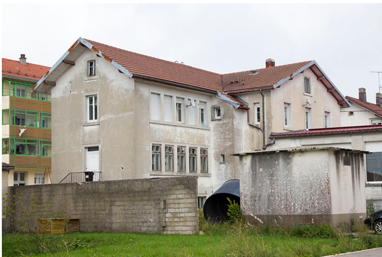
Façades postérieure et latérale droite.
