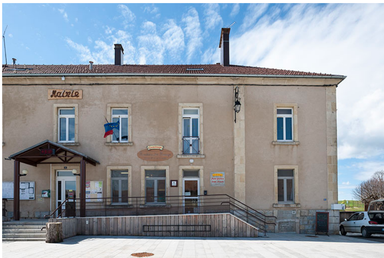
Façade nord (partie fromagerie).
