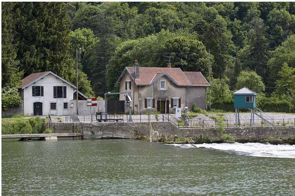
Besançon : site d'écluse n° 52 de Velotte.
