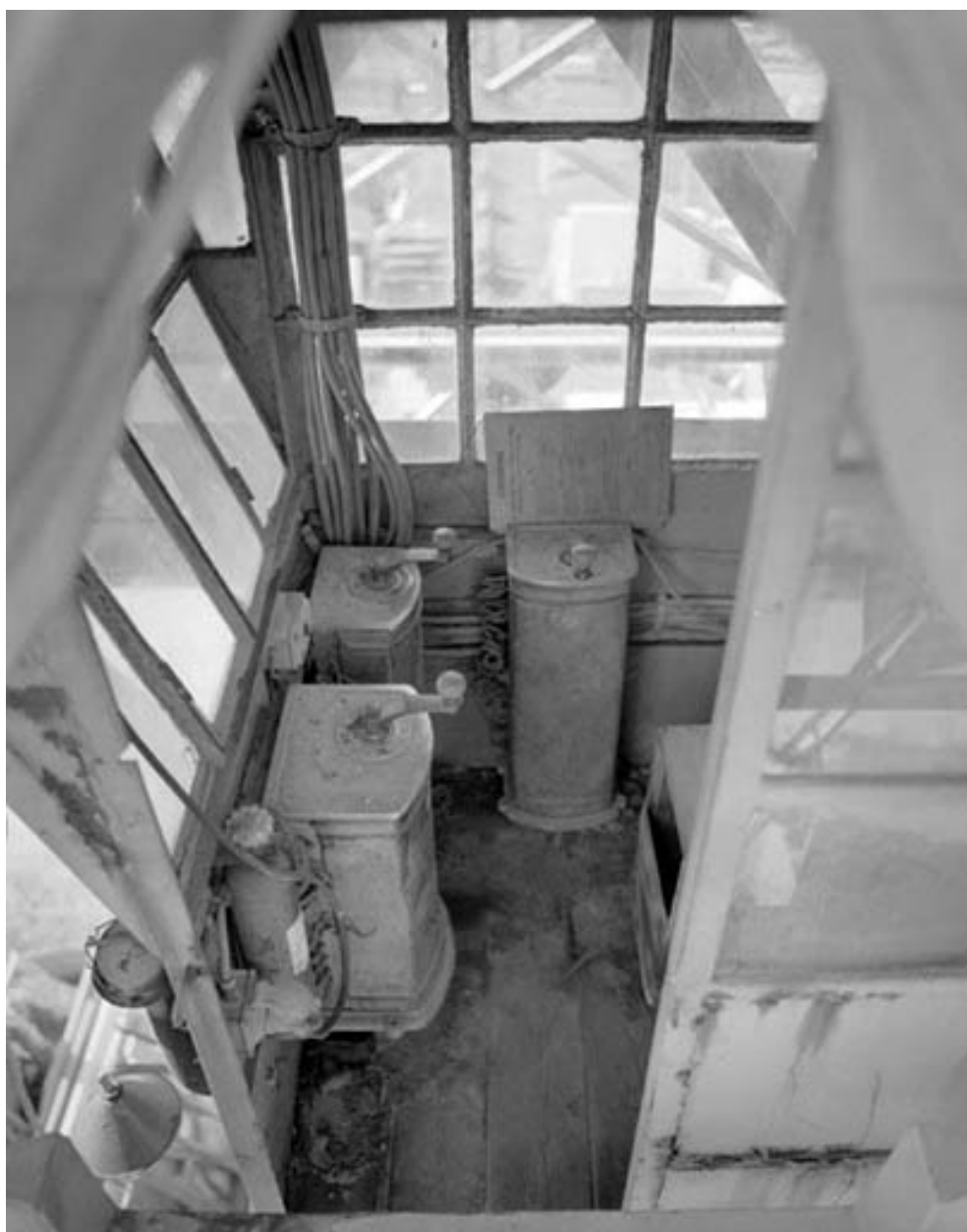
Intérieur de la cabine.
