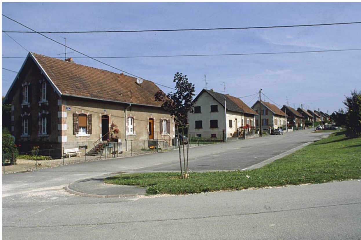
Vue d'ensemble de la rue des Combes.
