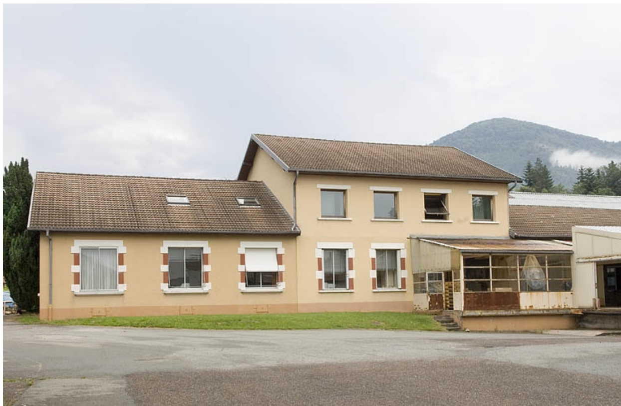
Façade sud des bureaux.
