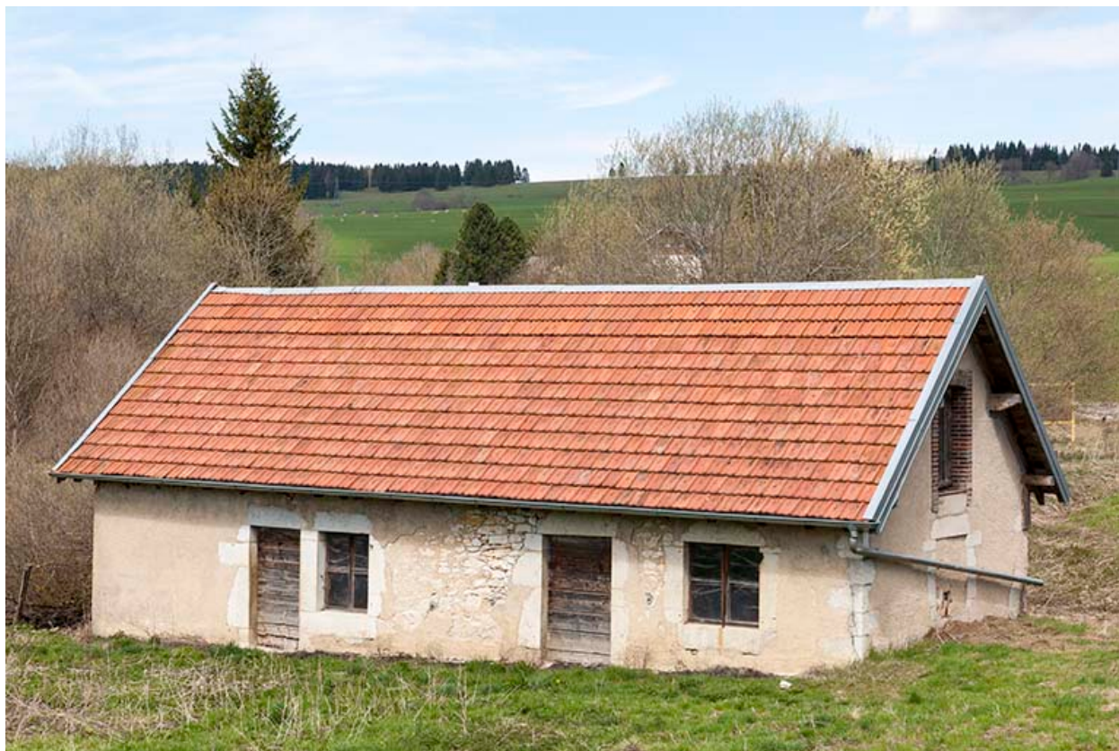
Ancien atelier de forge. Façade sud.
