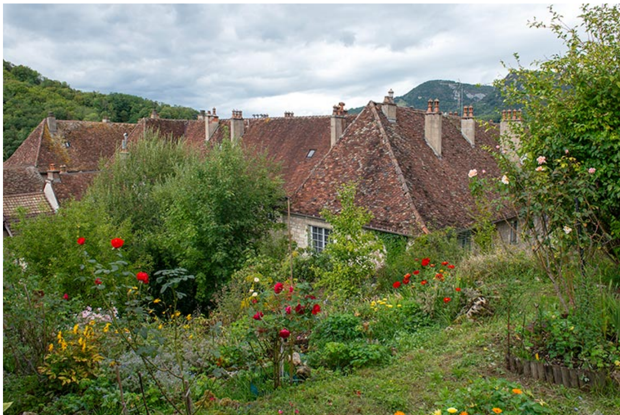
Toitures du couvent, depuis le sud-est.
