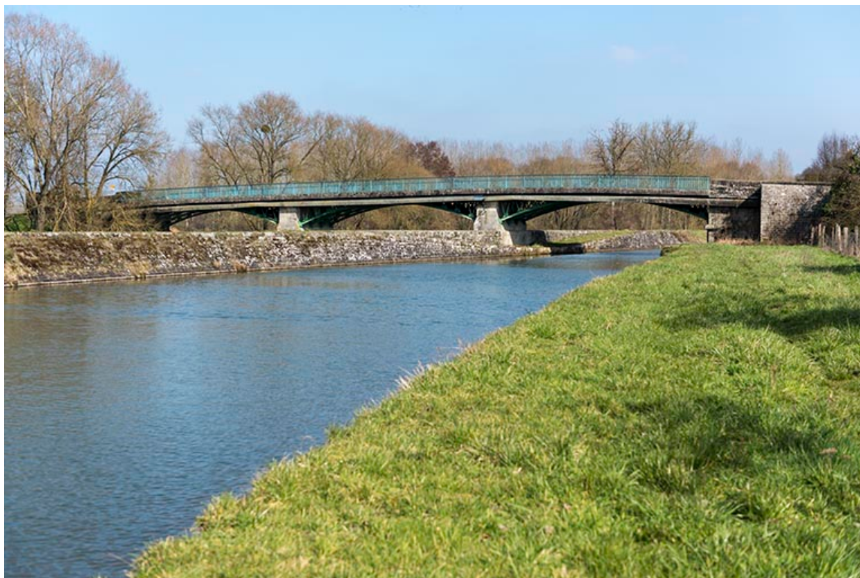
Vue depuis l'aval
