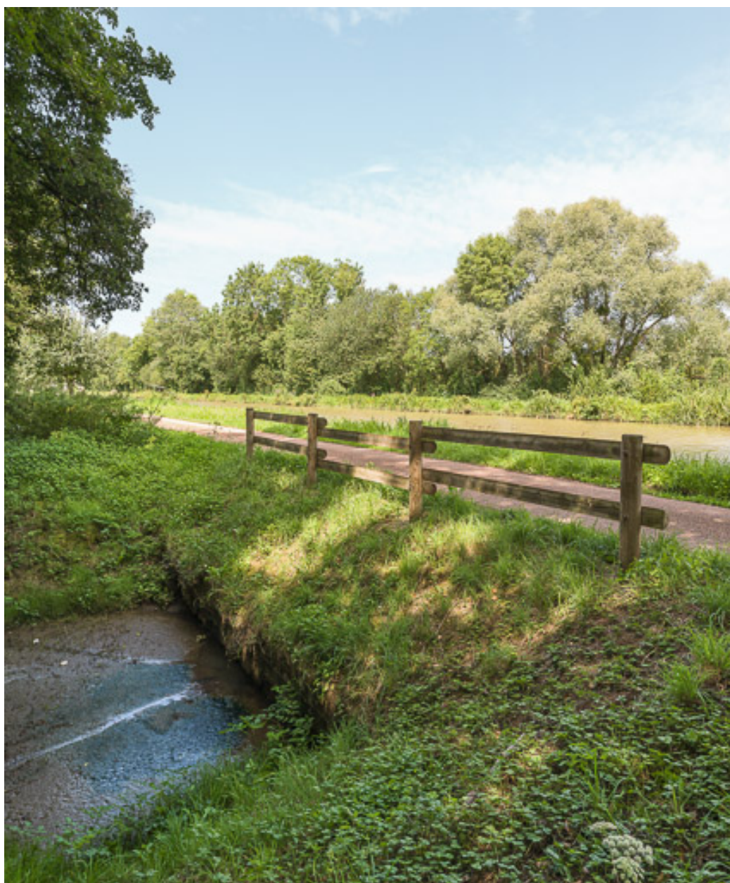
Vue de l'aqueduc.
