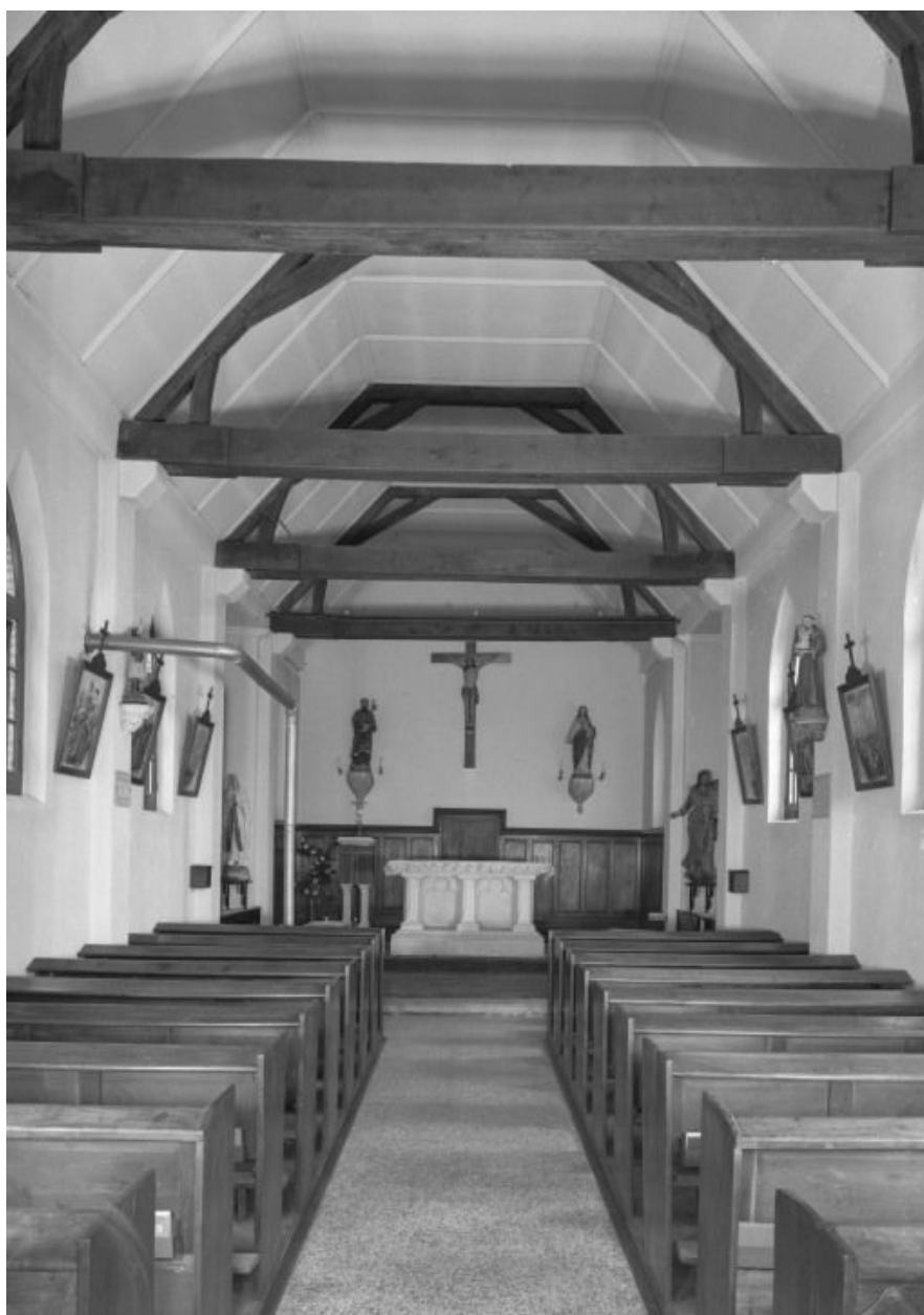
Vue intérieure prise depuis l'entrée
