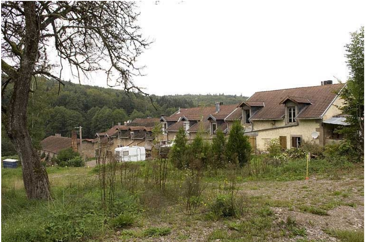
Halle et logements d'ouvriers depuis le sud-est.
