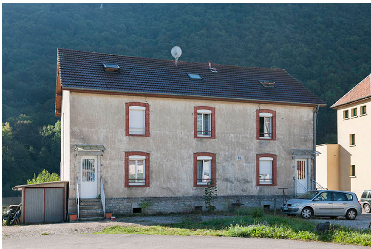
Logement ouvrier (sud) à 4 appartements. Façade ouest.
