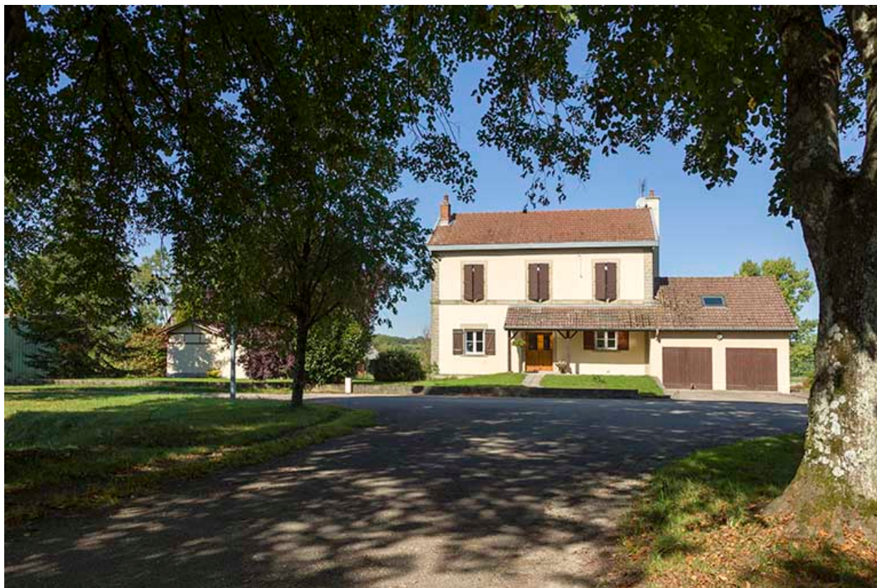
Façade sud-est de l'ancienne gare.
