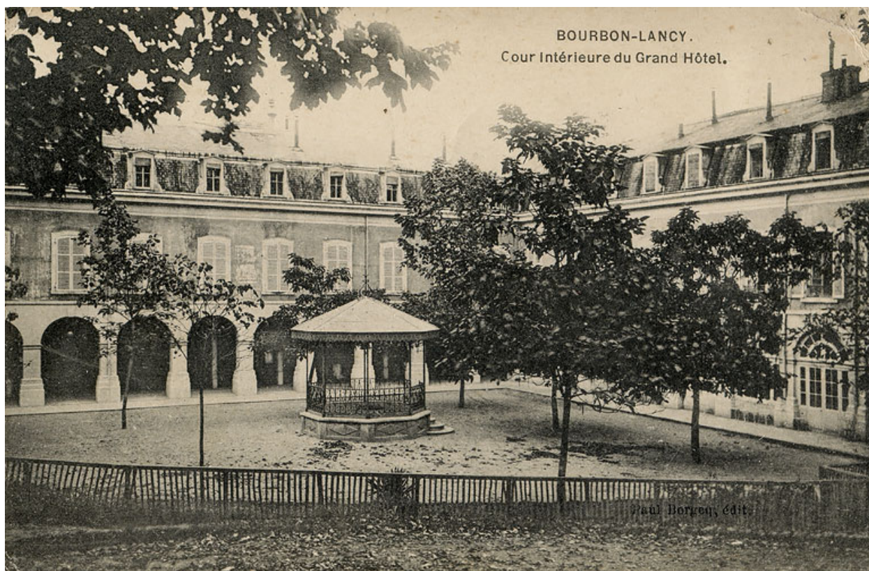
Cour, vue ancienne.
