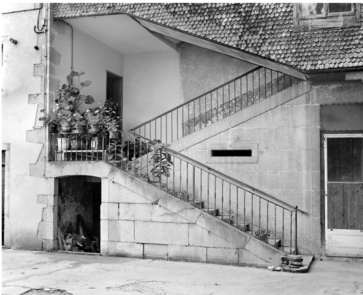
Escalier sud : cage ouverte au rez-de-chaussée.
