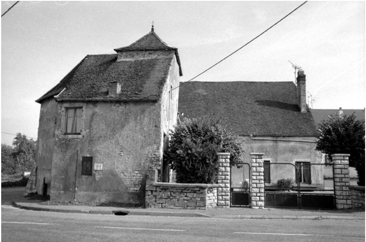
Façades sur cour.
