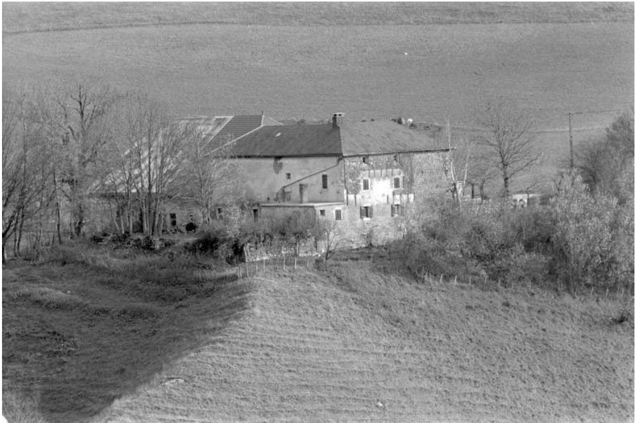
Vue rapprochée de la façade nord-ouest.
