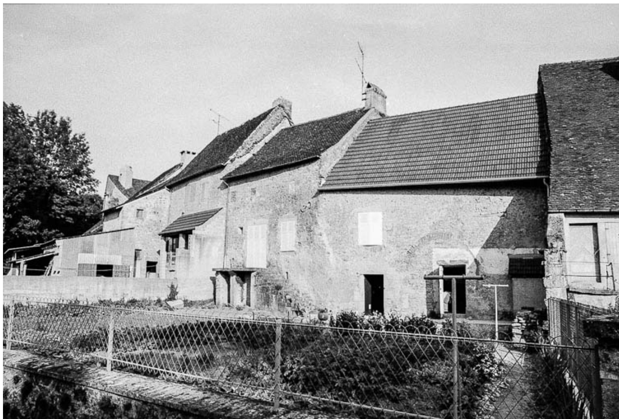
Maisons cadastrées 1960 AI 97 à 101, situées rue du Puits : façades postérieures.
