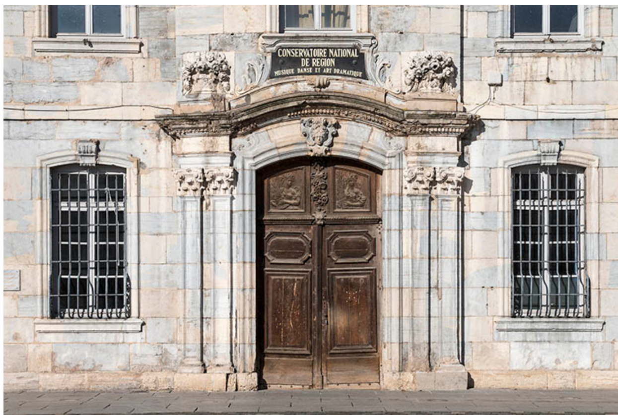
Portail et ses pilastres composites.
