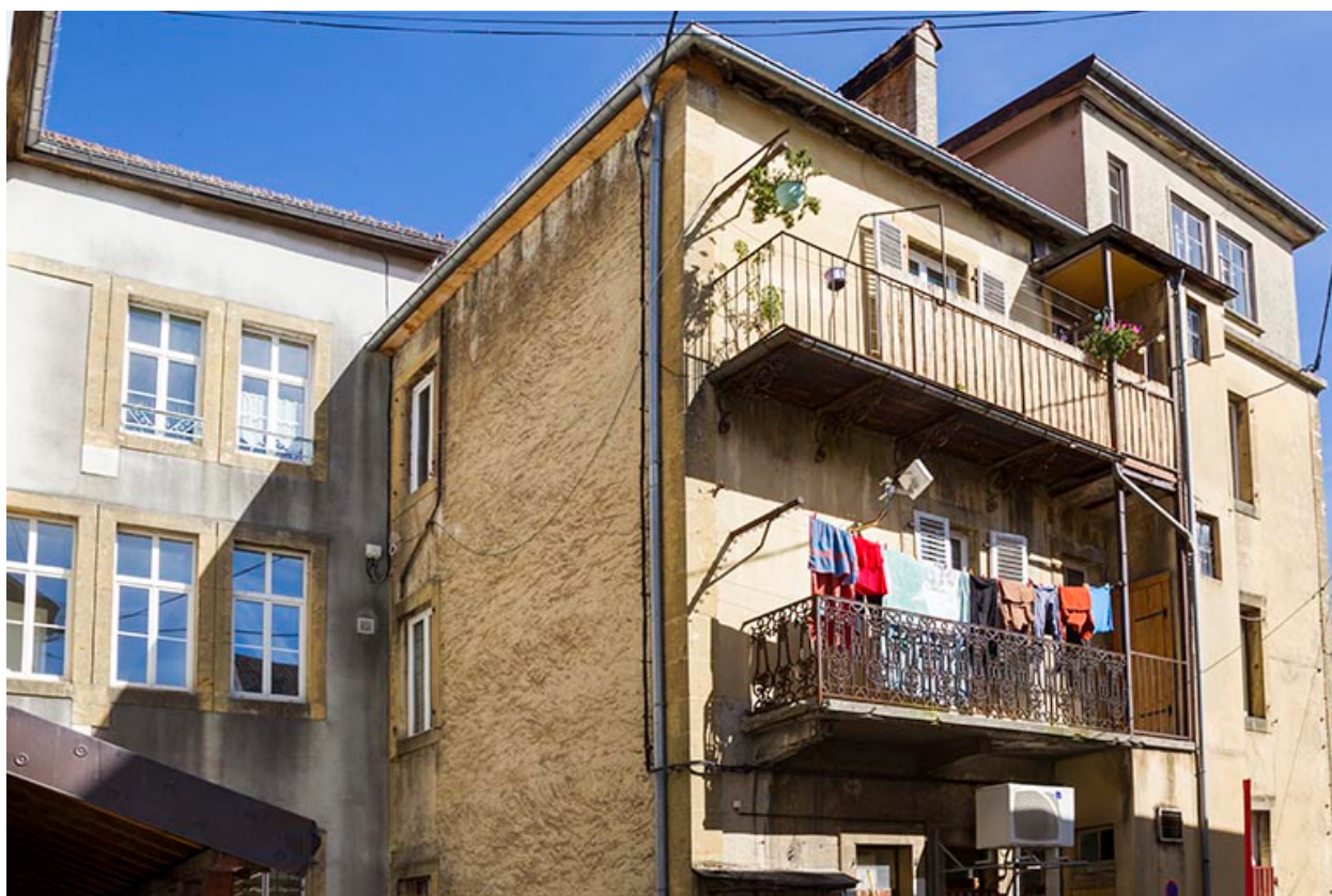
Façades postérieure et latérale droite.
